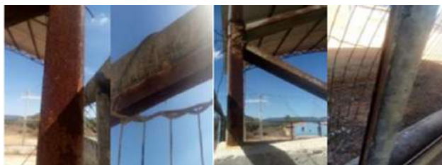
Figura 5: Corrosão uniforme
