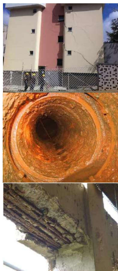
Figura 1.a – Fissuras no concreto. Fonte: http://www.emorar.com.br/trinca-em-paredes-sinal-de-que-o-imovel-corre-risco/ . Acesso em: 24 jul. 2018; 1.b – Corrosão em esgotos. Fonte: http://himipex.com/trunk-pipelines-corrosion-protection . Acesso em: 24 jul. 2018; 1.c – Corrosão por sais. Fonte: https://www.slideshare.net/camilaantunes/corros-o-em-concreto/4 . Acesso em: 24 jul. 2018
