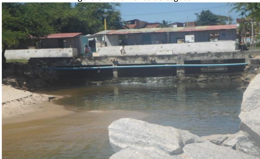
Figura 6. Vazamento de esgoto.
