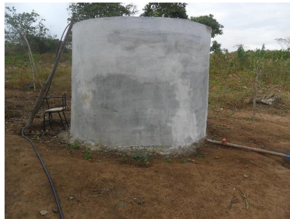
Figura 1. Construção de cisterna de ferrocimento no Assentamento Maria Preta, Araçagi-PB.
