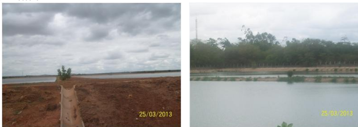
Figura 1. (A) Lagoa de estabilização das cajazeiras em Mossoró-RN. (B) Lagoa de estabilização do Vingt-Rosado em Mossoró-RN.
