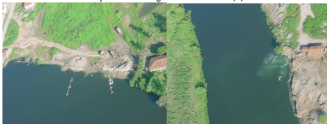
Figura 1: Imagens áreas das margens do Rio Apodi-Mossoró. Degradação das margens (A) e lançamento de esgotos não tratados (B).
