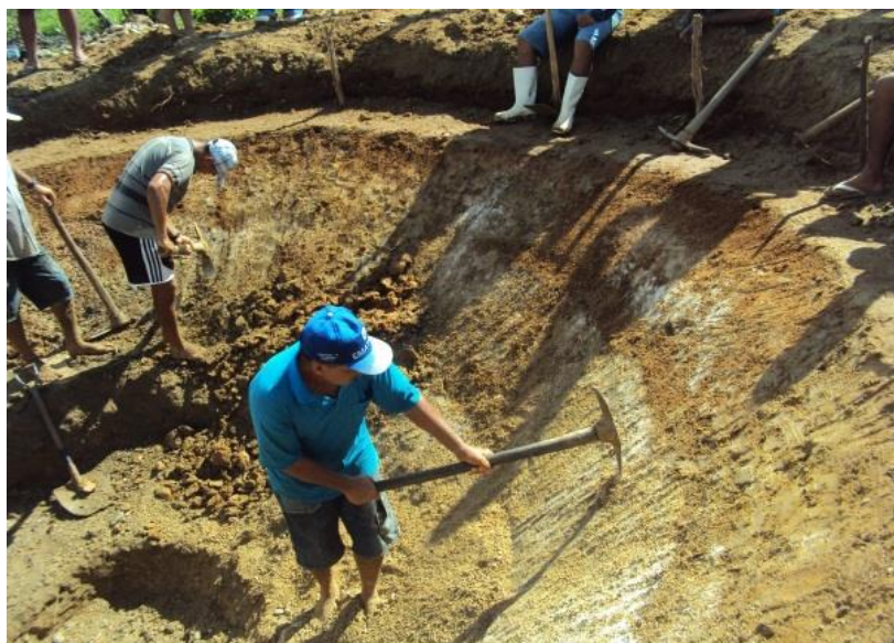
Figura 1. Escavação do tanque de irrigação.
